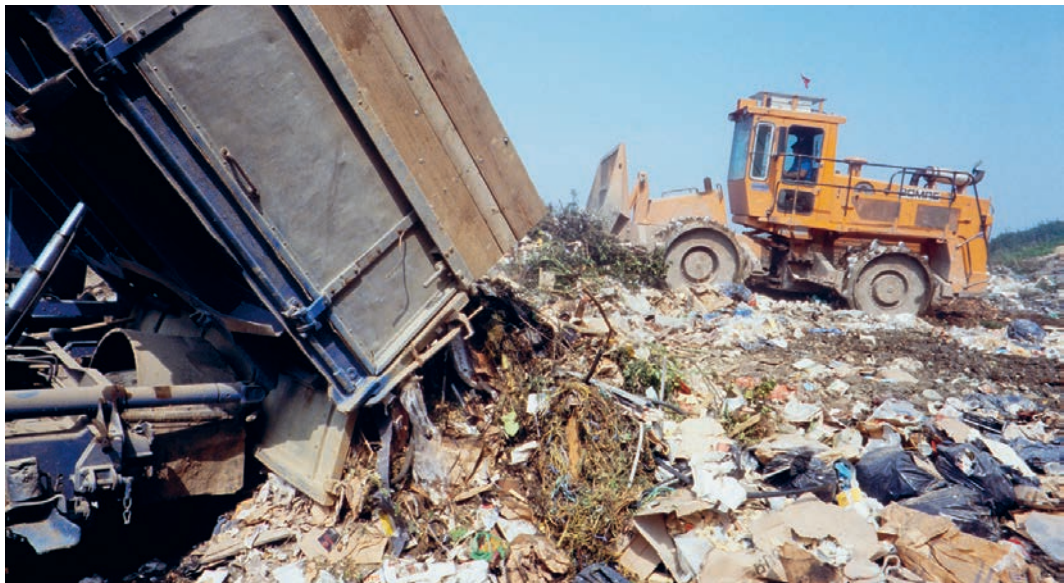
Blick in die Sondermülldeponie «Bärengaben» in Würenlingen (Kanton Aargau) in den 1980er-Jahren. In der Deponie wurden bis 2010 rund 3,5 Mio. Kubikmeter Siedlungsabfälle und Sondermüll vergraben.
