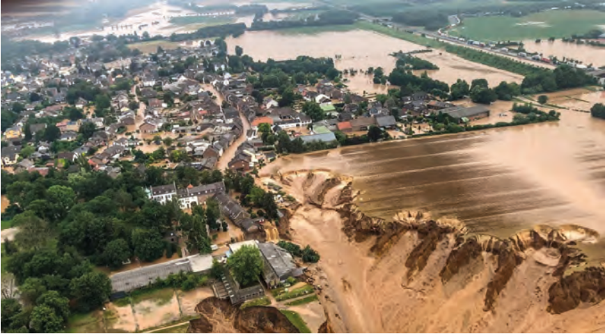
Fig. 22 Dévastations induites par les crues de l'été 2021 en Allemagne et en Belgique : le forçage d'une rivière dans une canalisation souterraine sous-dimensionnée provoque un énorme glissement de terrain, dans la commune de Erftstadt-Blessem (Rhénanie-Palatinat). Photo Les Échos / Reuters (DR).
