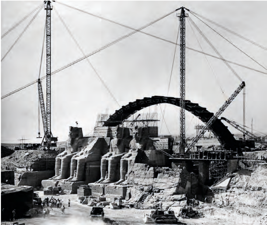
Fig. 11 Les prouesses de l'ingénierie moderne : sauvetage par l'UNESCO des temples antiques d'Abou Simbel en haute Égypte, vers 1966. Photo Reitz/Ullstein via Getty images et Mashable.
