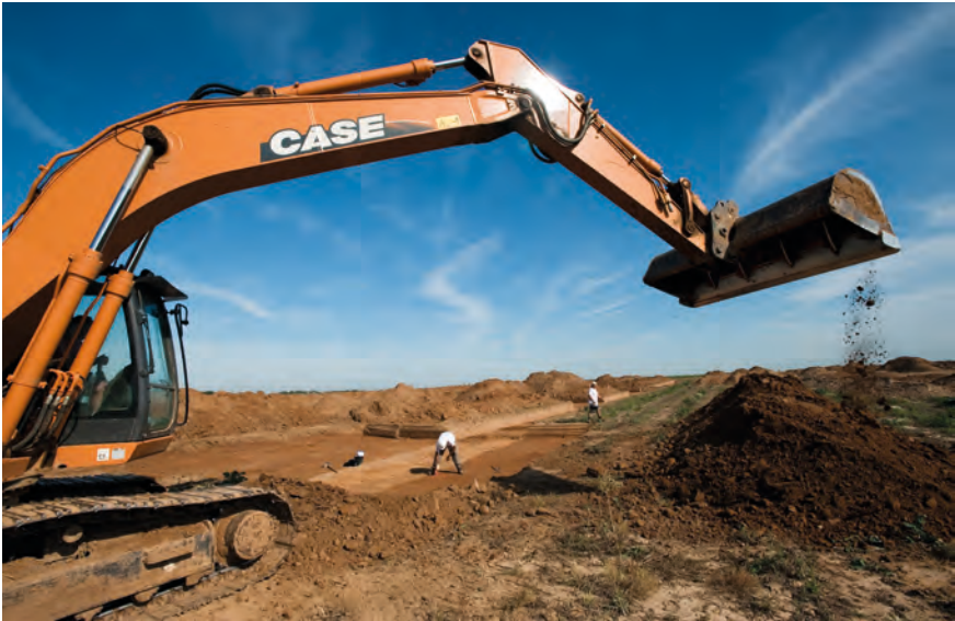
Fig. 18 Le recours massif à la « pelle rétro » munie d'un godet lisse a transformé l'approche du terrain archéologique et permis l'identification de traces diffuses, jusqu'alors imperceptibles. Photo Denis Glikman, Institut national de recherches archéologiques préventives, Paris.
