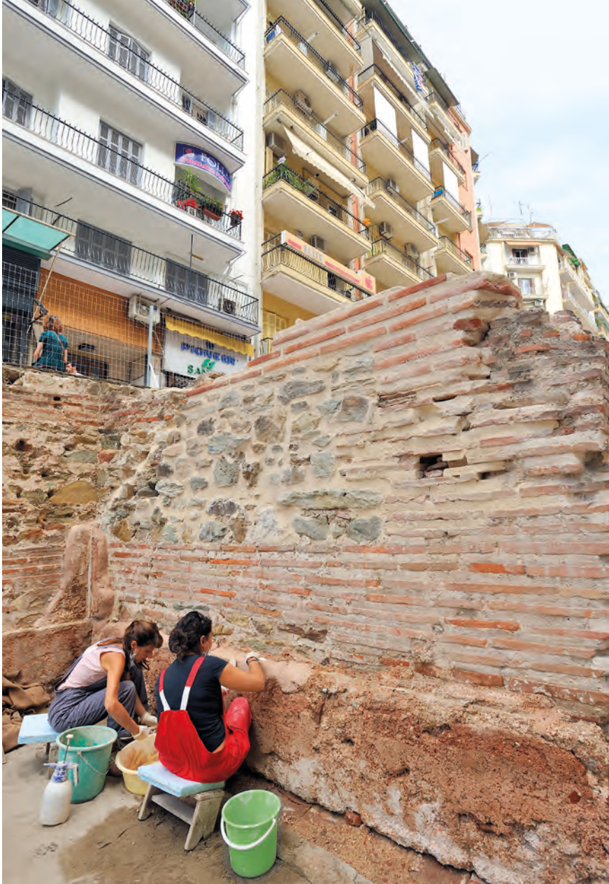
Fig. 21 Le prestige de l'Antiquité au cœur de quartiers d'habitations populaires. Travaux de restauration sur les ruines du Palais césarien de Galère (vers 300 de notre ère) à Thessalonique (Grèce). Photo et copyright Pierre Buch.
